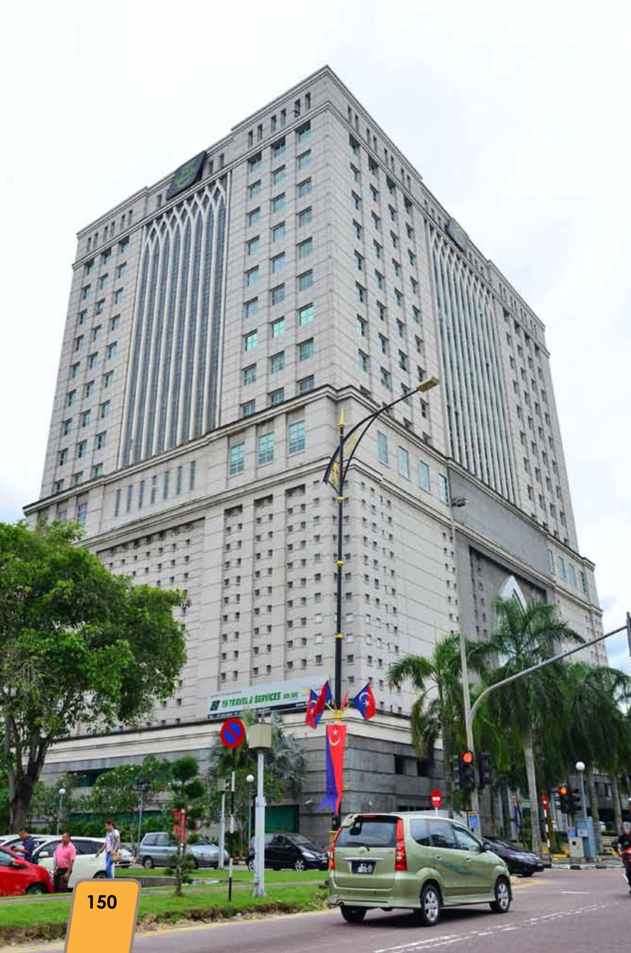
Bangunan Lembaga Tabung Haji
