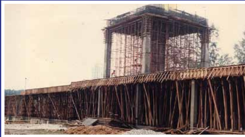
Dataran Bandaraya di awal pembinaannya
