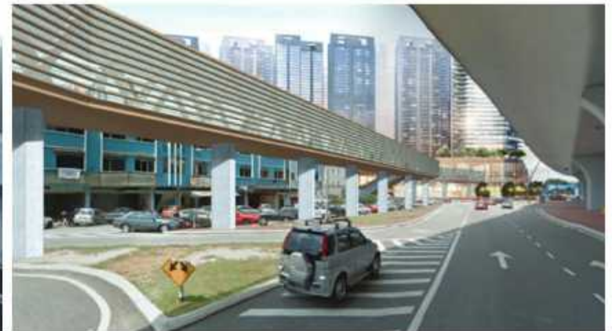
Pedestrian Linkbridge sepanjang 800 meter dari pembangunan R&F ke JB Sentral. An 800 metres pedestrian link bridge connecting R&F development to JB Sentral.
