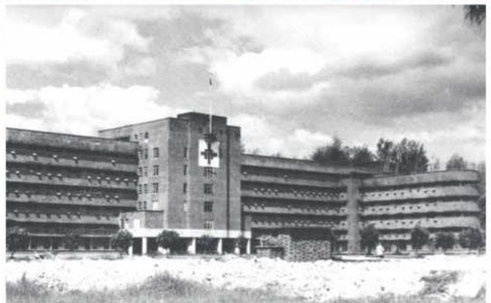
Bangunan Hospital Sultanah Aminah setelah siap dibina pada tahun 1941 dan digunakan sehingga kini. The Sultanah Aminah Hospital building after the construction completed in 1941 and used to date.
