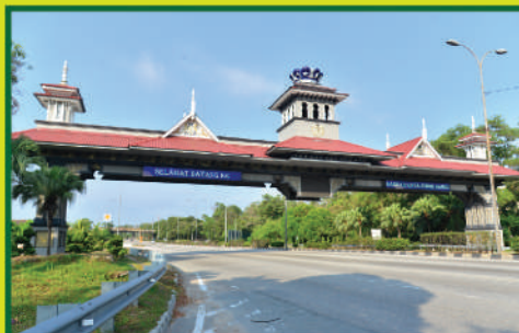
Gerbang Jalan Skudai
