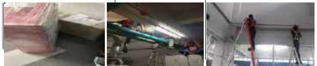
Kerja Pemasangan Lif Bangunan Jotic
