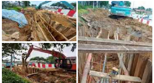
Gambar 3.39: Kerja-kerja Mengganti Paip Pembetulan Kumbahan di Jalan Daya, Taman Daya, Johor Bahru
