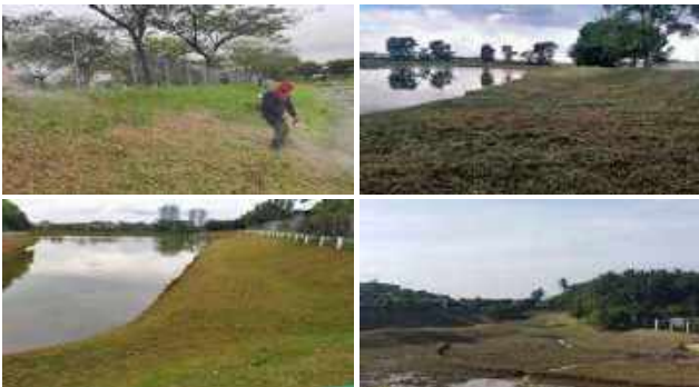
Gambar 3.24: Kerja-kerja penyelenggaraan Kolam Tadahan.
