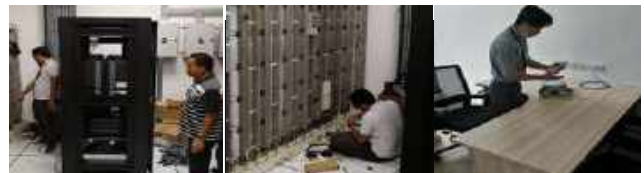
Kerja Pemasangan Sistem Telefon Di Menara Mbjb
