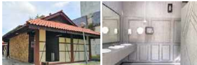
Gambar 3.17: Kerja-kerja menaiktaraf Tandas Awam di Tepian Tebrau Majlis Bandaraya Johor Bahru
