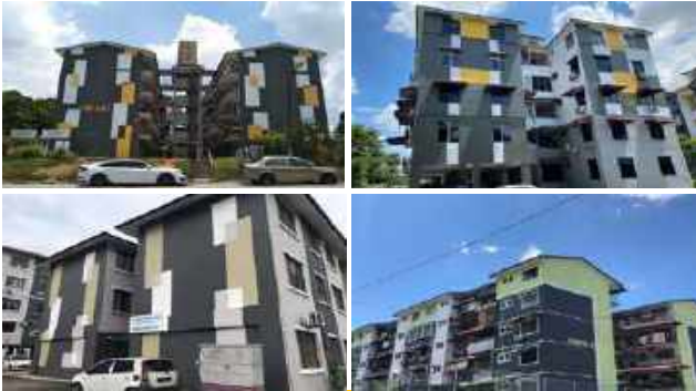
Gambar 4.8: Kerja-Kerja Mengecat Di Rumah Pangsa Blok 5 Taman Cempaka, Rumah Pangsa Nibong 14, Rumah Pangsa Austin Perdana 4 Dan Rumah Pangsa Blok 19 Taman Cempaka, MB Johor Bahru
