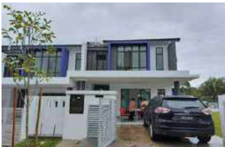
Pembangunan Rumah Teres 2 Tingkat Taman Bukit Tiram 2, Ulu Tiram, Johor Bahru
