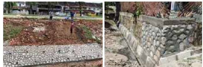
Gambar 3.26: Kerja Kerja Penyelenggaraan Pembaikan Struktur Saliran.
