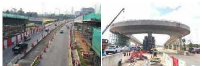
Gambar 3.9: Kerja-Kerja Membina Dan Menyiapkan Jalan Banjaran 5, Jalan Banjaran 10/1, Jalan Banjaran 10/3 Dan Jalan Banjaran 10/8 Serta Pembinaan Pembetung Kekotak Melintas Rizab Saliran Utama Dan Lain-Lain Kerja Berkaitan Mukim Pulai, Daerah Johor Bahru.
