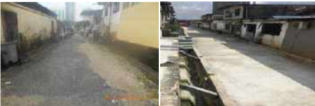
Gambar 3.5: Kerja Menaiktaraf Parit Di Lorong Belakang Jalan Harimau, Taman Abad Johor Bahru.
