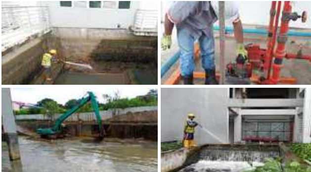
Gambar 3.35: Kerja Kerja Penyelenggaraan Loji Rawatan Kumbahan CSTP Segget, Johor Bahru.
