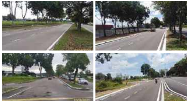
Gambar 4.4 : Kerja-Kerja Menurap Semula Jalan Dan Menyiapkan Garisan Jalan Serta Kerja-Kerja Berkaitan Di Taman Mount Austin, Johor Bahru.
