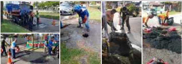
Gambar 3.18: Kerja Menampal Jalan.
