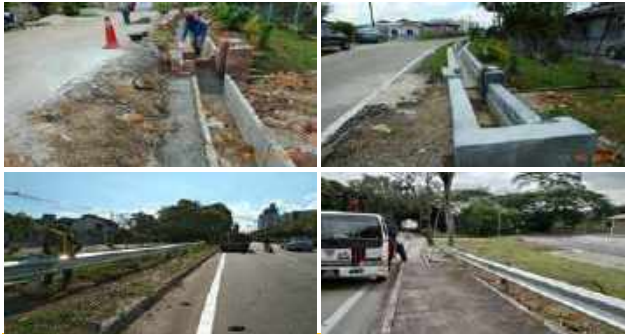
Gambar 3.4: Kerja-Kerja Penyelenggaraan Bahu Jalan.
