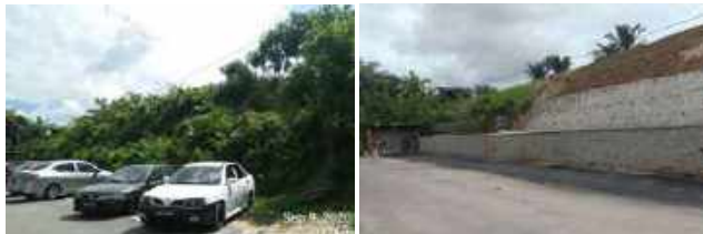
Gambar 3.28: Kerja-kerja Pembaikan Tembok Runtuh serta Kerja-kerja Berkaitan di Jalan Teratai 6, Taman Plentong Baru, Johor Bahru.
