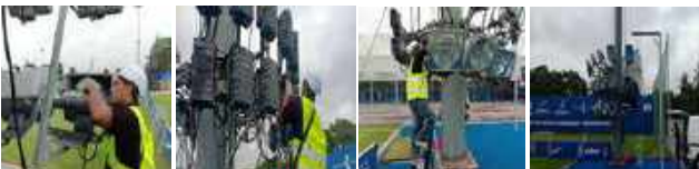
3.2.6 Kerja Penyelenggaraan Lampu Highmast
