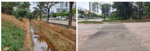
Gambar 3.32: Kerja Kerja Pembaikan Tebing Sg Serta Kerja Kerja Menggali Mendakan Di Alur Sg Pandan Bersebelah Jalan Jaya Putra Perdana, Johor Bahru
