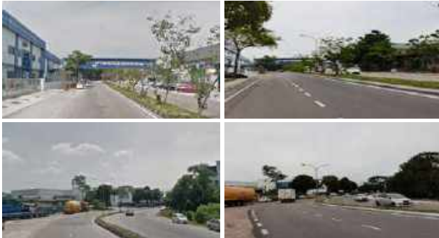
Gambar 4.1: Kerja-Kerja Pembaikan Jalan Serta Kerja-Kerja Berkaitan Di Kawasan Perindustrian Tebrau 1, Johor Bahru.
