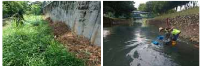
Gambar 3.25: Kerja Kerja Penyelenggaraan Pembersihan Sungai Dan Parit Utama
