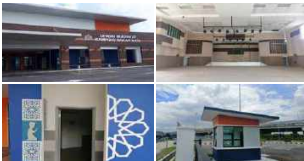
Membina Dan Menyiapkan Sebuah Dewan Serbaguna Kg. Bakar Batu (Dewan Muafakat Johor) Dan Padang Bola Serta Kerja-Kerja Berkaitan Atas Rizab Pembentungan Najis, Jalan Jambatan, Kg. Bakar Batu, Johor Bahru.
