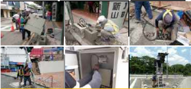
3.2.3 Kerja-Kerja Penyelenggaraan Lampu Isyarat
