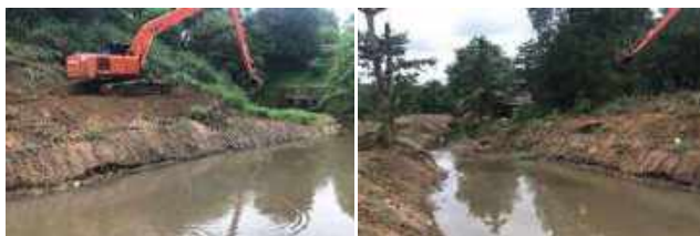
Gambar 3.29: Kerja-kerja Menggali dan Membersihkan Mendakan di Sg Sebulong, Jalan Tiong, Larkin Jaya, Johor Bahru.
