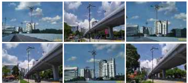
3.2.8 Kerja Naik Taraf Lampu Jalan Jenis Dekoratif Di Lingkaran Dalam Dan Jalan Ismail Sultan
