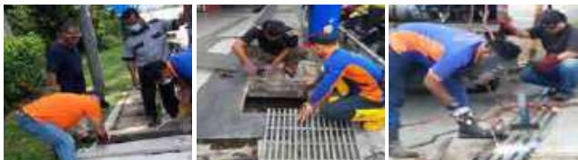
Gambar 3.20: Kerja Menggantikan Penutup Parit Rosak/Hilang.
