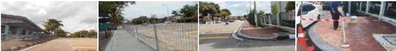
Gambar 4.13: Kerja-Kerja Memasang Pagar Keselamatan, Pembaikan Laluan Pejalan Kaki Dan Bebendul Jalan Serta Kerja-Kerja Berkaitan Di Jalan Padi Mahsuri, Jalan Padi Ria Jalan Padi Ria 1 Bandar Baru Uda Johor Bahru Di Bawah Program Bandar Selamat.
