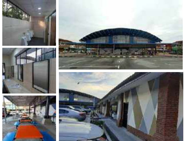
Gambar 3.16: Kerja-kerja Menaiktaraf dan Kerja-kerja Berkaitan di Pasar Awam Setia Indah Majlis Bandaraya Johor Bahru.
