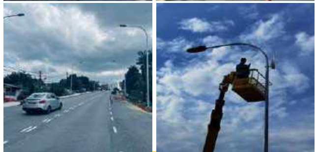
3.2.7 Kerja-Kerja Membekal Dan Memasang Lampu Jalan Di Jalan Dato Jaafar, Larkin, Johor Bahru
