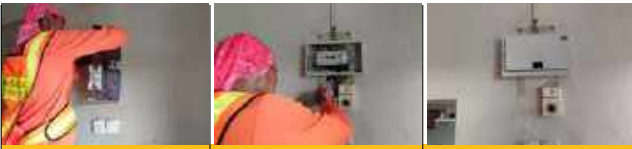
Kerja Penyelenggaraan Elektrik Bangunan
