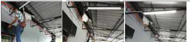
Kerja Penyelenggaraan Elektrikal Gerai & Medan Selera
