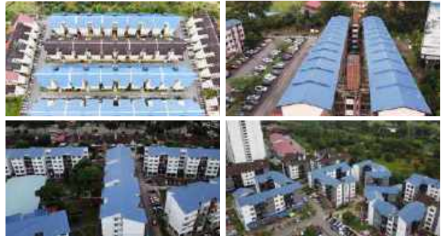
Gambar 4.7: Kerja-Kerja Pembaikan Bumbung Di Rumah Pangsa Daisy Taman Plentong, Rumah Pangsa Blok 13 Taman Melor, Rumah Pangsa Pinang 3 Taman Daya Dan Rumah Pangsa Fasa 3G & 3H Taman Molek, MB Johor Bahru.
