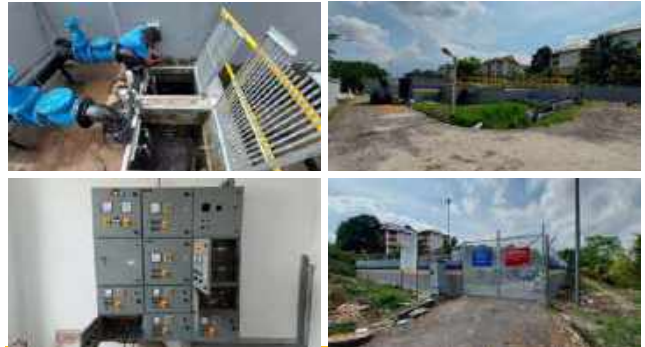
Gambar 3.38: Kerja-kerja Pembaikan Pengoperasian LRK Jalan Impian 6 (JBBT59) dan Rumah Pam Jalan Impian Utama (JBBT60), Taman Impian Skudai, Johor Bahru
