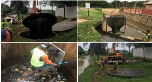
Gambar 3.23: Kerja-kerja penyelenggaraan GPT.
