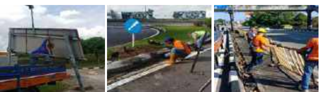
Gambar 3.19: Kerja Membaiki Papan Tanda Lalulintas Dan Perabut Jalan.
