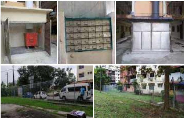
Gambar 4.10: Kerja-Kerja Infrastruktur Awam Di Rumah Pangsa Blok 10 Dan 19 Taman Cempaka, MB Johor Bahru.
