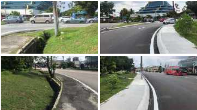
Gambar 4.6: Membina Laluan Pejalan Kaki Di Jalan Puyuh Dan Jalan Cenderawasih, Larkin, MB Johor Bahru.
