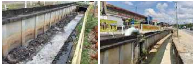
Gambar 3.31: Kerja kerja Pembaikan Tebing Sungai Bala Di Bersebelahan Jalan Tampoi, Taman Ungku Mohsin, Johor Bahru, Serta Kerja Kerja Berkaitan.
