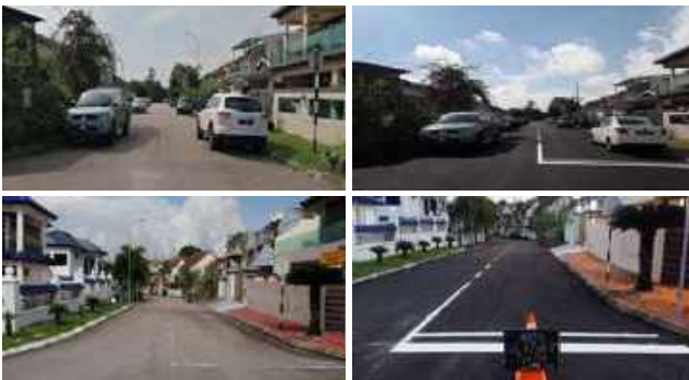
Gambar 4.2: Kerja-Kerja Menurap Semula Jalan Dan Menyediakan Garisan Jalan Serta Kerja-Kerja Berkaitan Di Taman Desa Tebrau, Johor Bahru.
