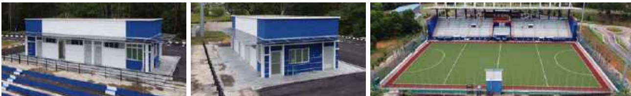
Gambar 4.12: Kerja-kerja Menaiktaraf Fasiliti di Stadium Hoki Taman Daya, Sempena Sukan SUKMA XX JOHOR 2020.
