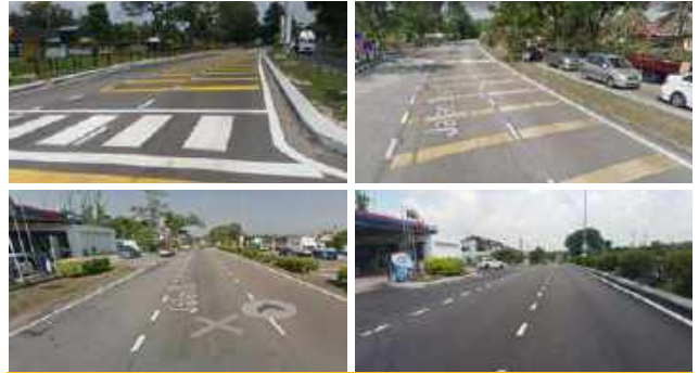
Gambar 4.3: Kerja-Kerja Menurap Semula Jalan Dan Menyediakan Garisan Jalan Serta Kerja-Kerja Berkaitan Di Taman Daya, Johor Bahru.
