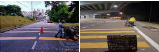
Gambar 3.3: Kerja-Kerja Penyelenggaraan Garisan Jalan, (Road Marking).
