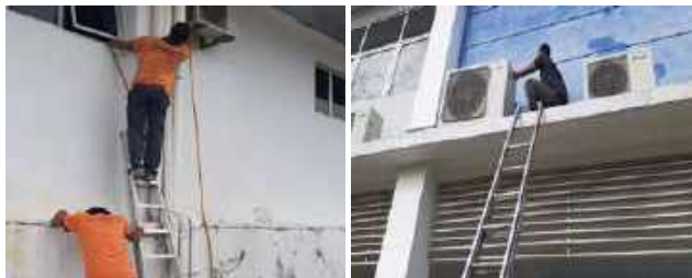
Kerja-Kerja Penyelenggaraan Sistem Air Cond Split Unit
