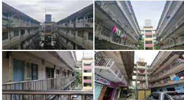
Gambar 4.9: Kerja-Kerja Pembaikan Susur Tangan Di Rumah Pangsa Blok 3 Taman Cempaka, Rumah Pangsa Blok 19 Taman Cempaka Dan Rumah Pangsa Kenanga 5 Taman Kenanga, MB Johor Bahru.
