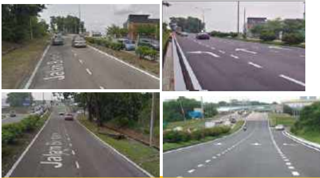
Gambar 4.5: Menaiktaraf Jalan Bertam 23, Taman Daya Dan Persimpangan Bertingkat Lebuhraya Pasir Gudang, MB Johor Bahru.
