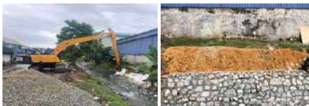
Gambar 3.33: Kerja-kerja Pembaikan Tebing Parit Utama Desa Cemerlang Di Jalan Mahir 1, Taman Perindustrian Cemerlang, Ulu Tiram, Johor Bahru Serta Kerja-kerja Berkaitan
