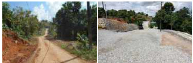
Gambar 3.8: Kerja-Kerja Membina Dan Menyiapkan Jalan Banjaran 5, Jalan Banjaran 10/1, Jalan Banjaran 10/3 Dan Jalan Banjaran 10/8 Serta Pembinaan Pembetung Kekotak Melintas Rizab Saliran Utama Dan Lain-Lain Kerja Berkaitan Mukim Pulai, Daerah Johor Bahru.
