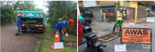
Gambar 3.2: Kerja-Kerja Penyelenggaraan Parit Tertutup, (Storm Sewer).
