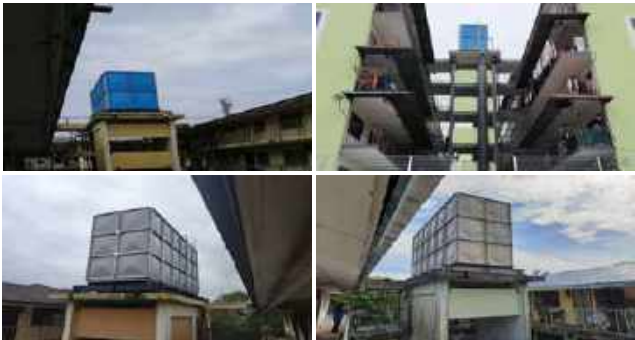
Gambar 4.11: Kerja-Kerja Pembaikan Tangki Di Rumah Pangsa Blok 17, 19 Dan 22 Taman Cempaka, MB Johor Bahru.
