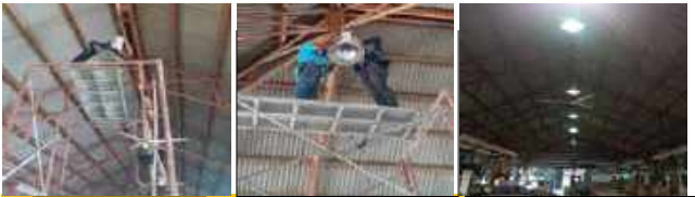
Kerja Penyelenggaraan Elektrikal Pasar Awam
