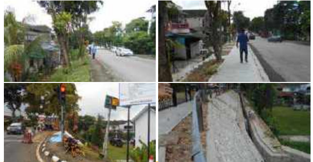
Gambar 3.7: Kerja Menaiktaraf Perparitan Di Cerun Jalan Padi Dan Jalan Barli, Bandar Baru Uda, Johor Bahru.
