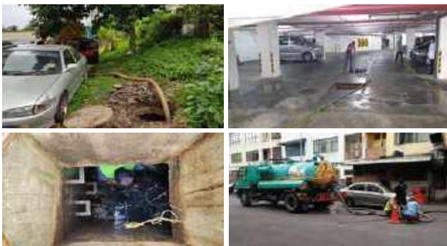
Gambar 3.37: Kerja Kerja Penyelenggaraan Pembersihan "Jetter Sewerage Pipeline".
