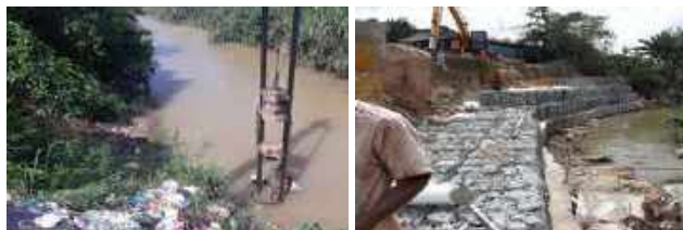
Gambar 3.34: Kerja-kerja Pembaikan Tebing Runtuh Sg Tiram di Taman Muhibbah, Ulu Tiram, Johor Bahru Serta Kerja-kerja Berkaitan
