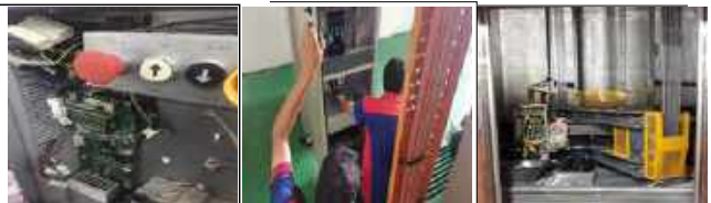
Kerja Penyelenggaraan Sistem Lif Bangunan
