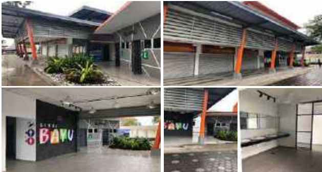
Gambar 3.15: Kerja-Kerja Menaiktaraf Anjung Selera Bayu (1), Perindustrian Tampoi, Johor Bahru.
