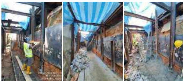
Gambar 3.30: Kerja-kerja Pembaikan Tembok Runtuh di Belakang Rumah di Jalan Rusa 4, Taman Abad, Johor Bahru.
