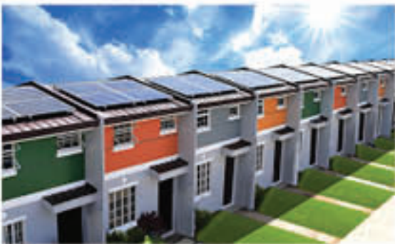
Solar di Kawasan Perumahan
